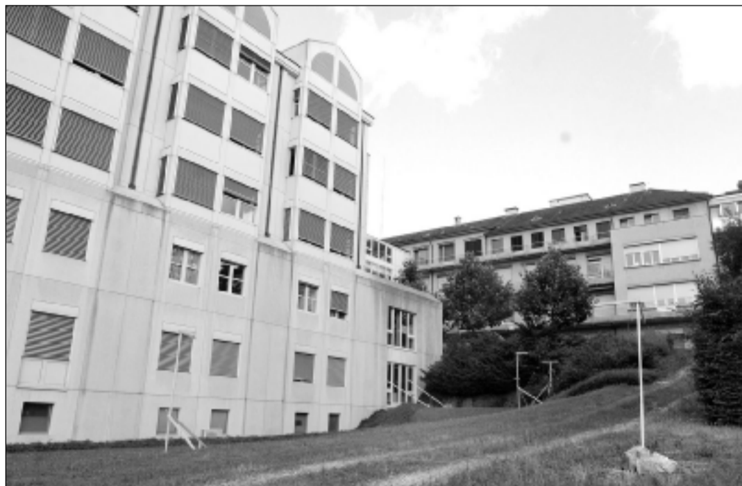
Placés à côté de l'annexe sud, neuf containers métalliques accueilleront une partie des vestiaires du personnel de l'Hôpital de Delémont.
